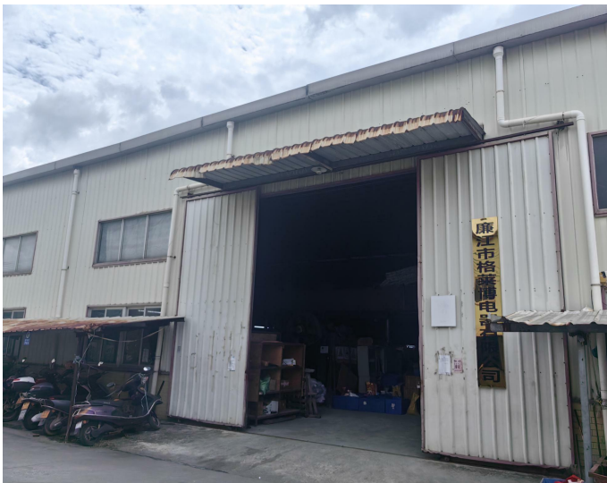
项目西北面：廉江市格莱博电器有限公司
